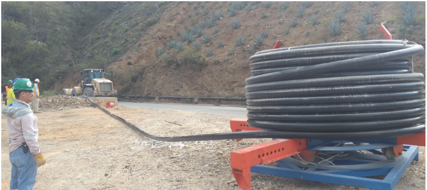
Instalación de tubería Pexgol para transporte de relave minero.
