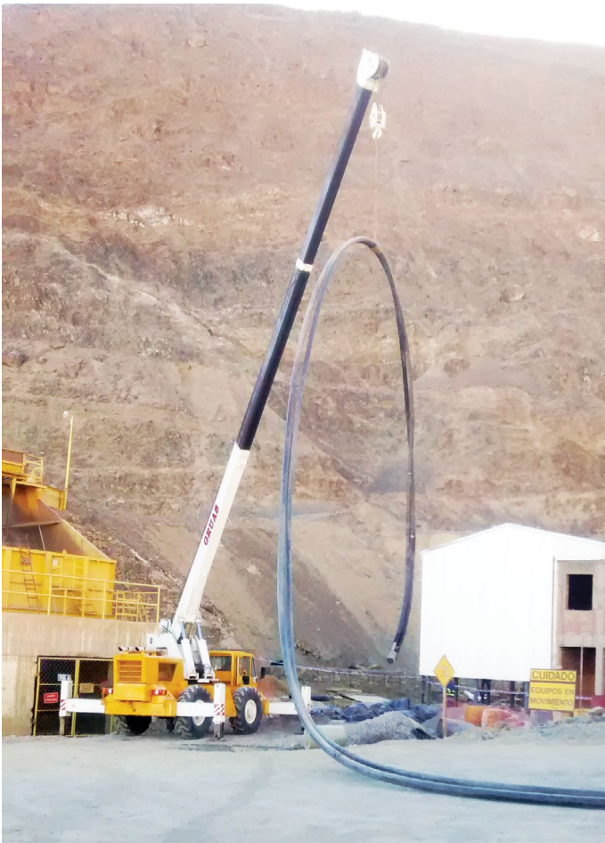
Introducción de tubos a mina
